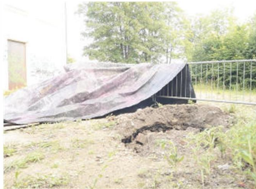
L'ultima voragine si è aperta sabato all'esterno
