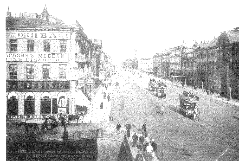
San Pietroburgo, Prospettiva Nevskij, vista dal ristorante Lejeune.
