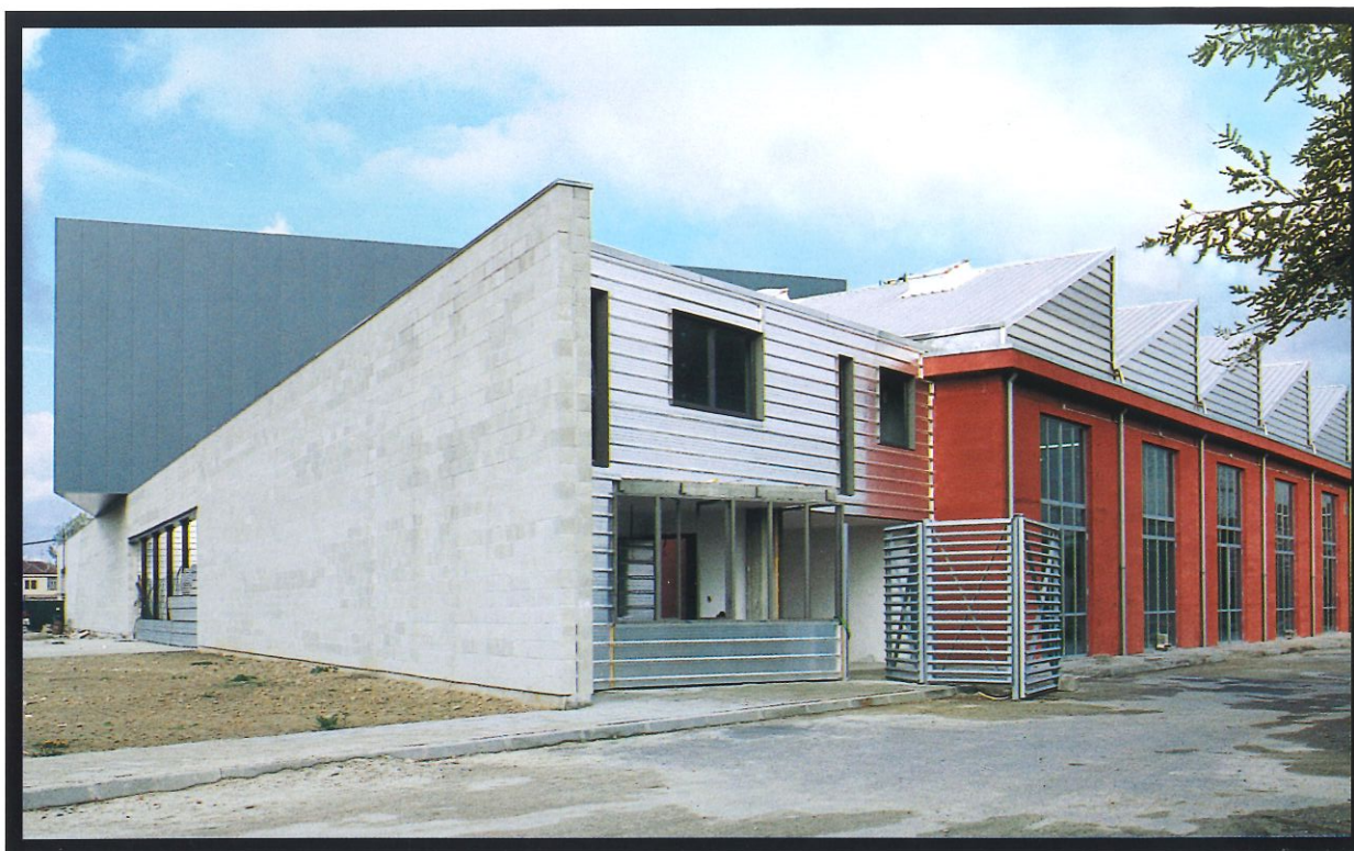
Fronte sud del complesso verso la città
