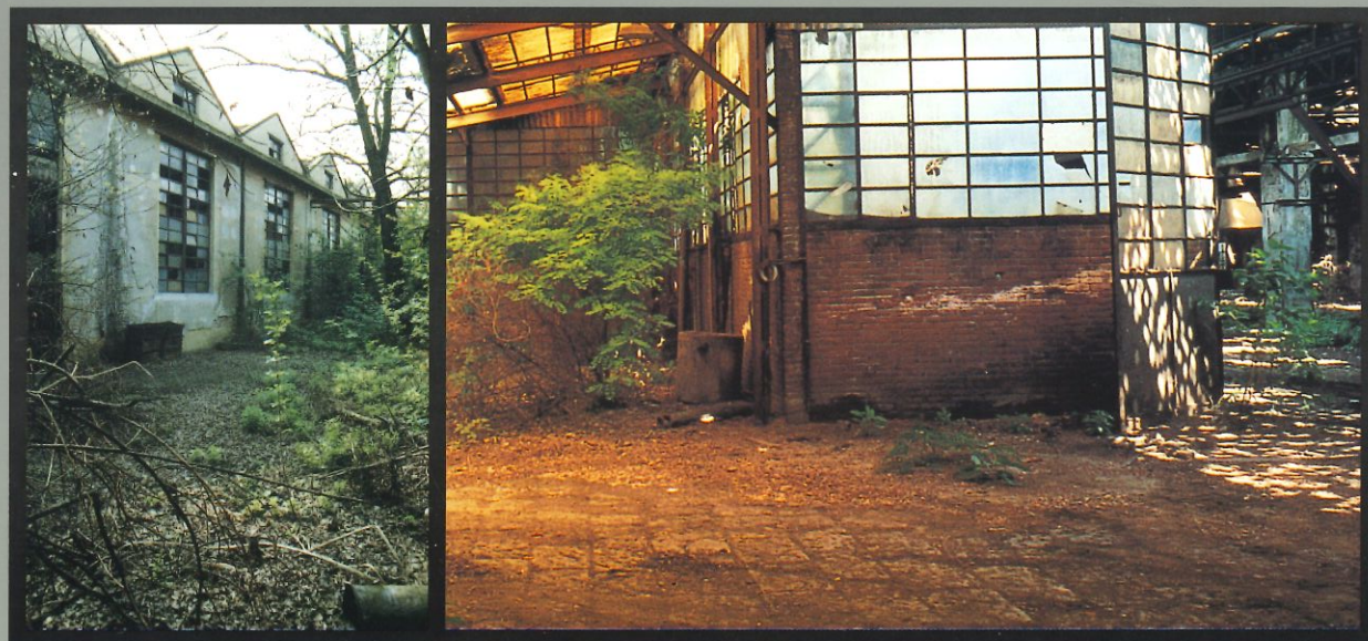
Corpo di fabbrica nord-est e pavimentazione lastricata in pietra.
