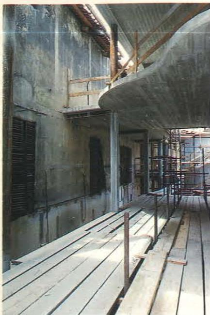
Sopra, una delle passerelle di collegamento truate in corrispondenza degli ultimi due piani: realizzate in cemento armato, accordano il vecchio corpo di fabbrica del teatro con le nuove strutture di servizio. Nella foto a destra, gli spazi della biblioteca che offrirà al pubblico nuove possibilità culturali. Sotto, la grande sala dello spettacolo durante i lavori di restauro.
